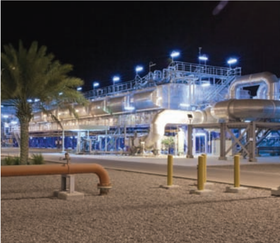
أكوا بركاء للطاقة - وحدة التبخير الومضي
