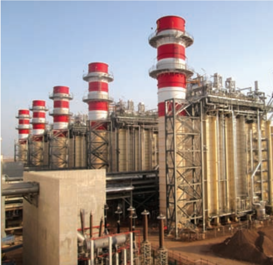
محطة صور لإنتاج الطاقة الكهربائية ( قيد الإنشاء )
